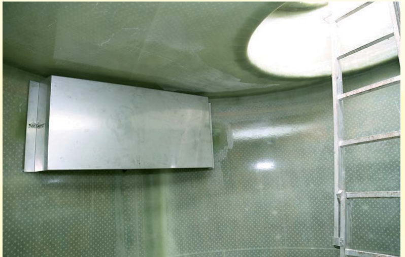
Sanierungsbedürftige Abscheider aus Beton können mit Platten aus Glasfaserverstärktem Kunststoff dauerhaft und preisgünstig ausgekleidet werden
