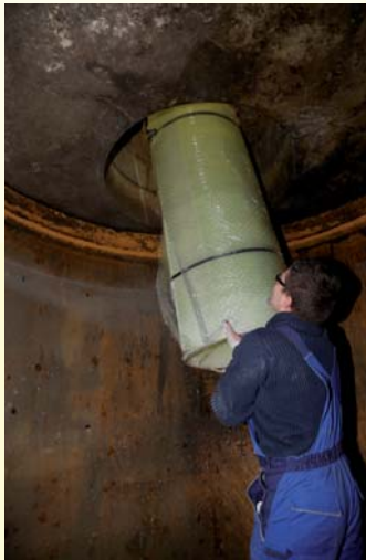
Sanierungsbedürftige Abscheider aus Beton können mit Platten aus Glasfaserverstärktem Kunststoff dauerhaft und preisgünstig ausgekleidet werden
